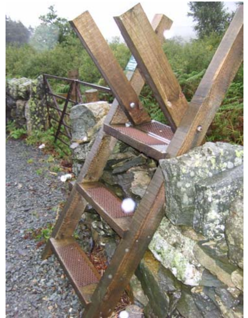
こちらは西部ウェールズ地方の伝統的な石垣に設けられたスタイル
